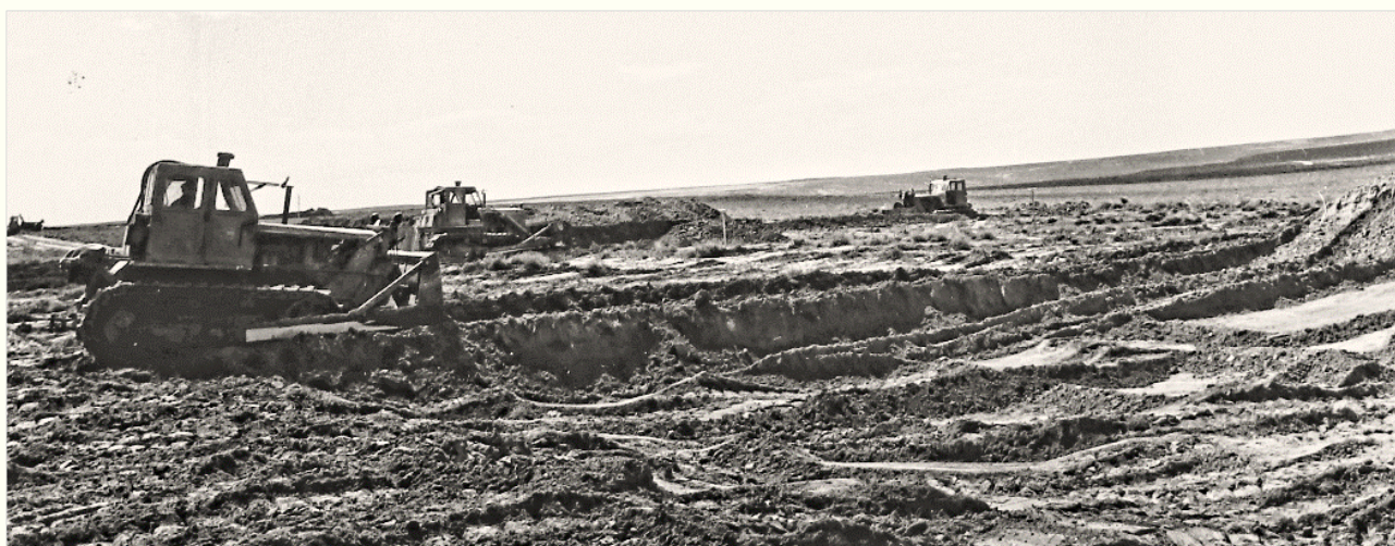
На смену верблюдам: строительство автодороги Навои-Зарафшан в 1958-1970 гг. Навоийский горный комбинат. г. Навои, Узбекская ССР. ЧУ «Центратомархив». Ф.55. Оп.1фд. Д.37. Л.6
