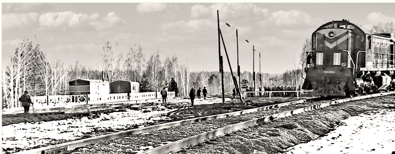
Станция «Заводская» на площадке изотопно-химического завода (ИХЗ ГХК). Горно-химический комбинат. г. Железногорск, Красноярский край. 1980 г. ЧУ «Центротомархив». Ф.55. Оп.1фд. Д.65.Л.8
