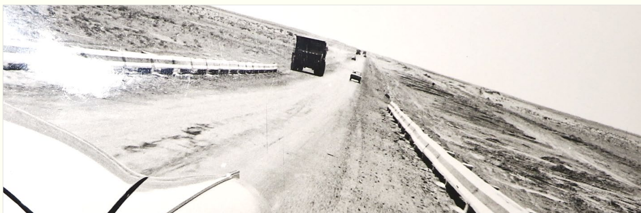
Автомагистраль Учкудук-Зарафшан. 1958-1970 гг. Навоийский горный комбинат. г. Навои, Узбекская ССР. ЧУ «Центротомархив». Ф.55. Оп.1фд. Д.37. Л.7
