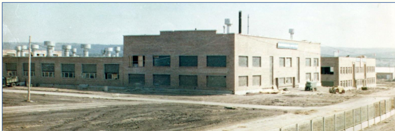
Животноводческий комплекс подсобного сельского хозяйства (совхоза «Искра») при УРСе Электрохимического завода (г. Красноярск - 45, 1977 г.). ЧУ «Центратомархив». Ф. 55. Оп. 1фд. Д. 32. Л. 29.
