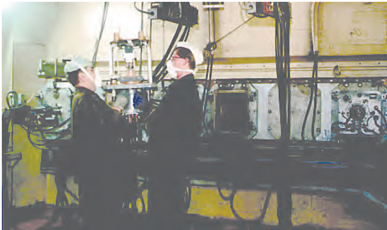
Монтаж установки СУ-20
