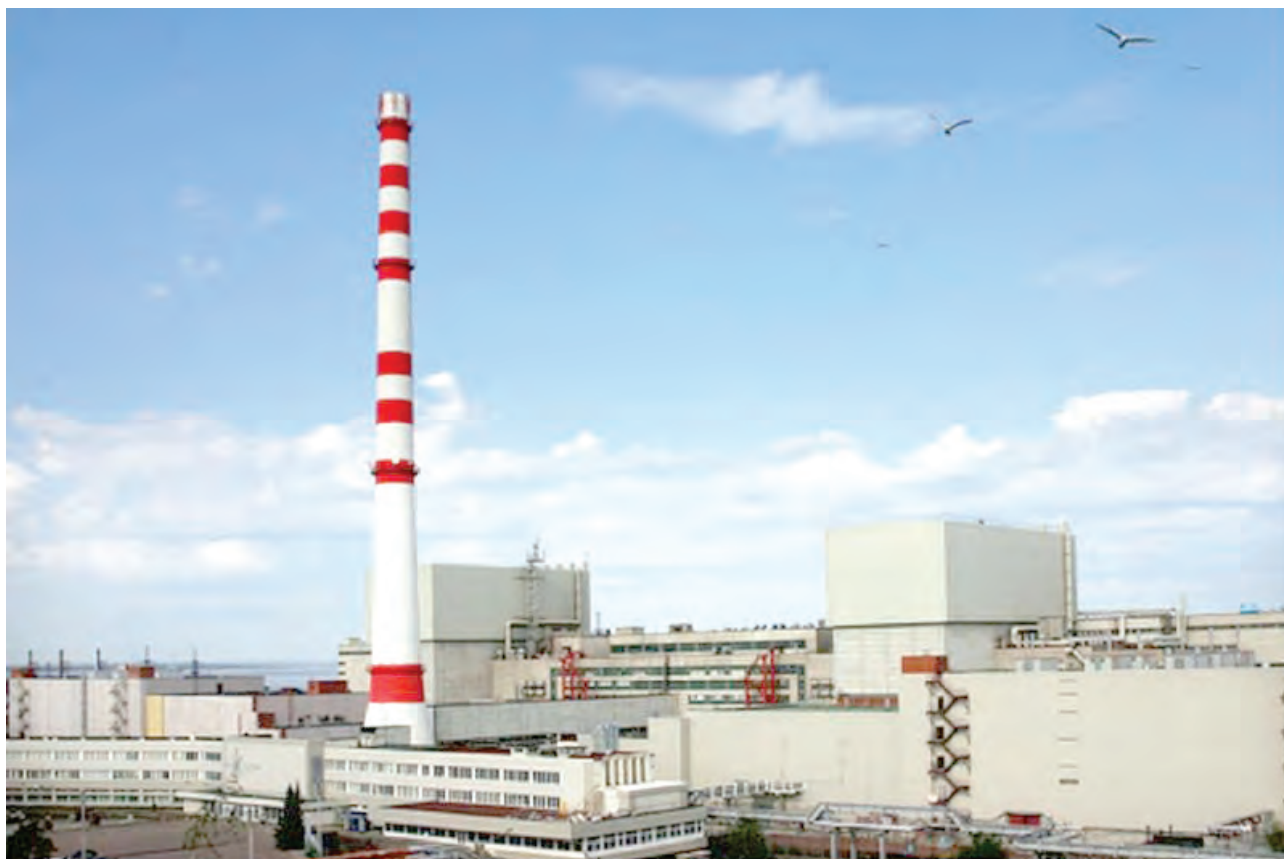
Ленинградская атомная станция
