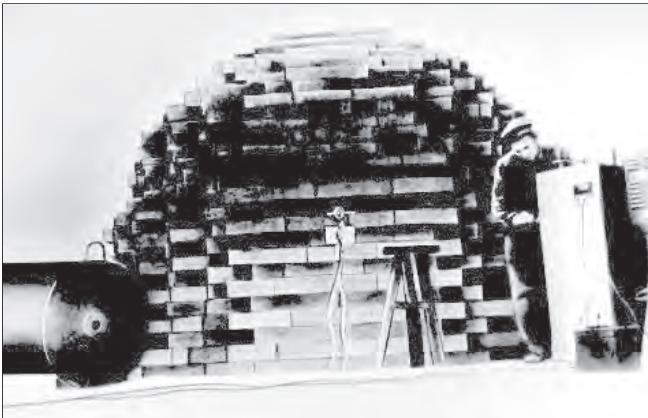
Первый исследовательский уран-графитовый реактор Ф-1
