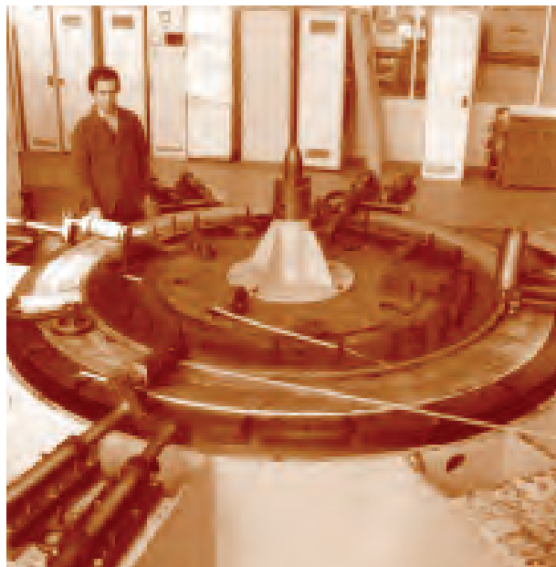
Сверхпроводящая намотка Токамак-15
